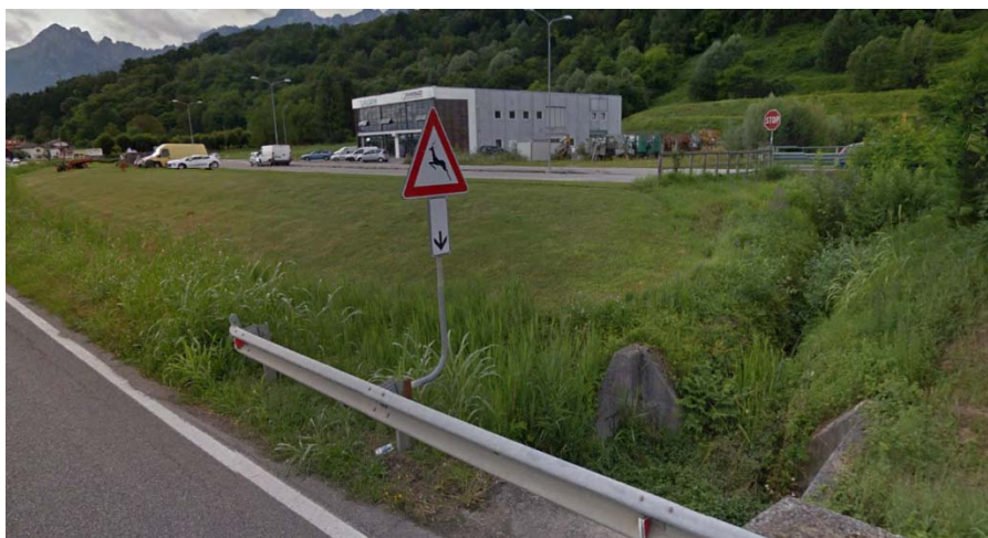
Figura 14-11 – Fossati da pulire e riprofilare a monte di Via Belluno.
