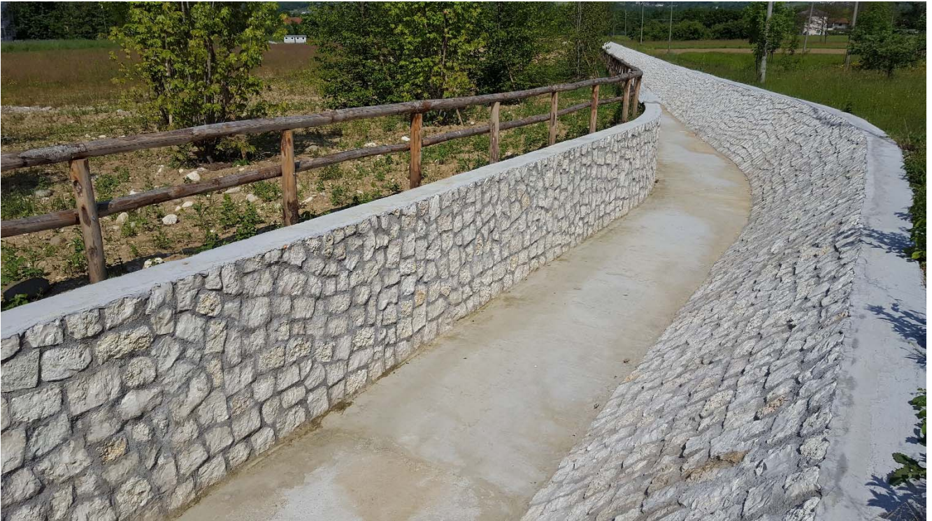
Figura 5-8 –Torrente Landrisio nel tratto recentemente sistemato con rivestimento in cls.
